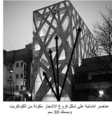
شكل (18) يوضح واجهة المبنى
