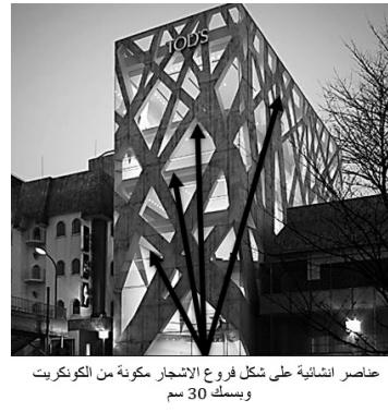
شكل (18) يوضح واجهة المبنى
