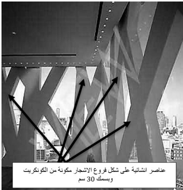
شكل (19) يوضح التصميم الداخلي للمبنى
